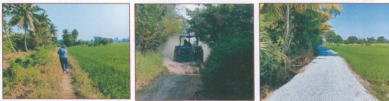
๑๒. โครงการปรับปรุงถนนลงหินคลุกผิวจราจร (สายข้างนายนายสำเนา) หมู่ที่ ๓ ตำบลตอนก้า
